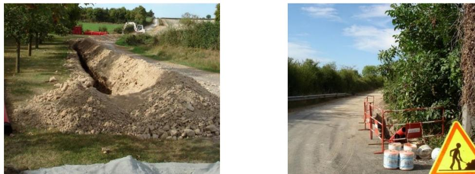
Figure 75 : Tranchée pour le raccordement au réseau local (source : VALOREM, 2015)
