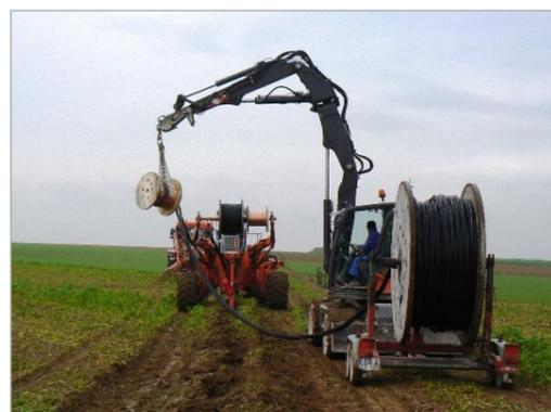
Figure 112 : Pose d'un câble HTA à 1,50 m avec la méthode du soc tracté (source Valorem, 2015)
